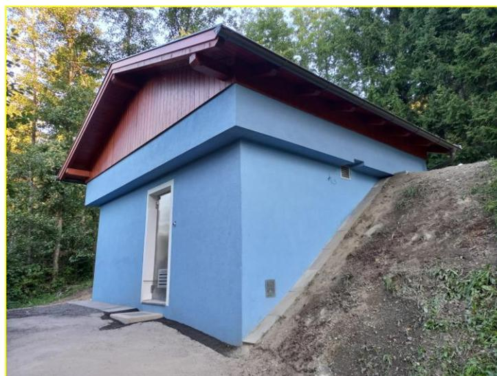
Der Hochbehälter für die Wasserversorgung der Gemeindefbürger in Breitenstein wurde in den letzten Monaten saniert. Es wurde eine Dämmung angebracht, das Dach und die Fassade erneuert.
